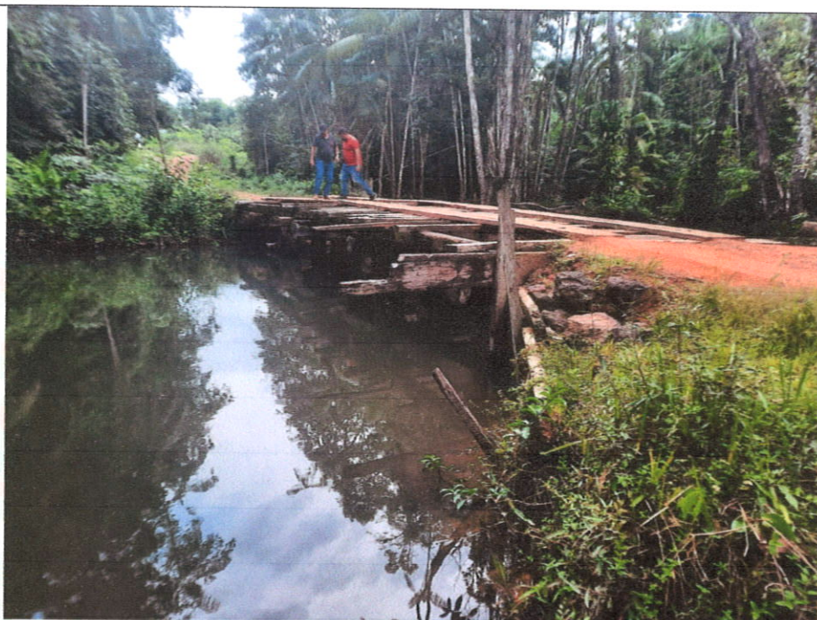
Imagem 3: Vista lateral da ponte.
