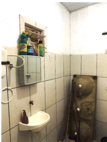
Figura 6 – Vista das demais instalações.
